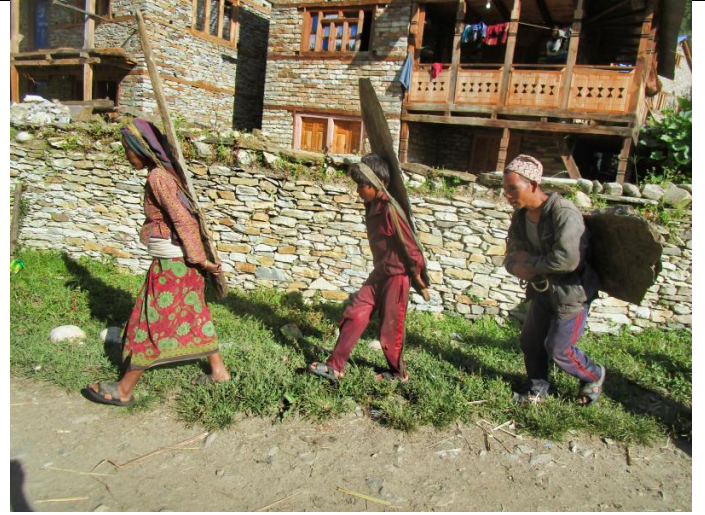
Bild 11: Um das Waldrodungen zu vermeiden, wird Holz als Baumaterial wenn immer möglich durch Stein ersetzt. Hier trägt eine Familie Schiefersteine zur Abdeckung ihrer Klärgrube ins Dorf.
