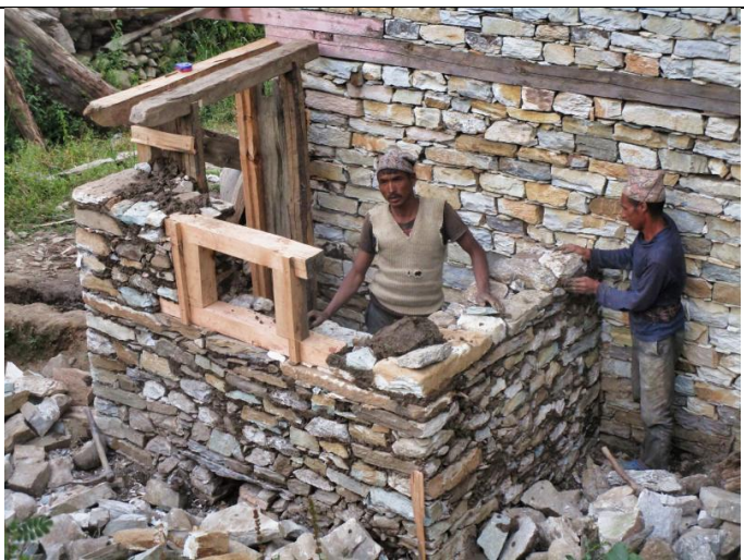
Bild 26: Das Beispiel einer weiteren Toilette, die von einer Familie direkt an ihr Haus angebaut wird.
