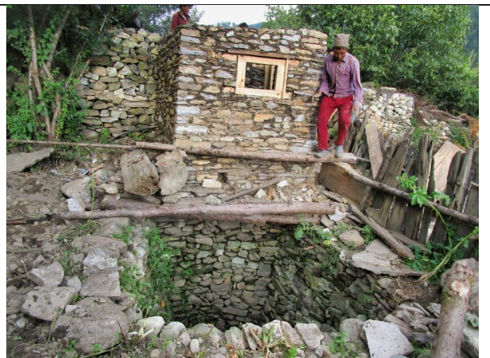
Bild 27: Blick auf eine Toilette und die abdeckbereite Klärgrube, in der die flüssigen und festen Abwässer gesammelt werden.
