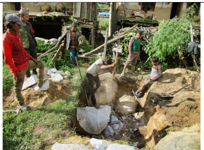
Bild 8: Die Arbeit wird oft durch grosse Felsbrocken erschwert. Diese werden mit Vorschlaghammern von Hand zerkleinert!
