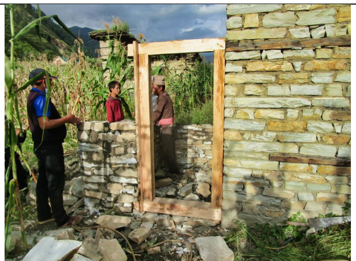
Bild 21: Da für einige Familien nicht genug Land für eine freistehende Toilette zur Verfügung steht, bauen sie diese direkt an ihr Haus an.
