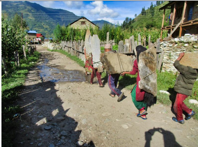
Bild 12: Die Schiefersteinplatten werden in einem nahe gelegenen Steinbruch vorbereitet und nach Hause getragen.
