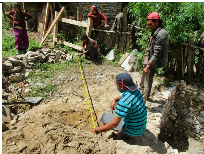
Bild 2: RIDS-Nepal Mitarbeiter Mansingh vermisst zusammen mit einer Familie das Steinhausfundament ihrer Toilette.
