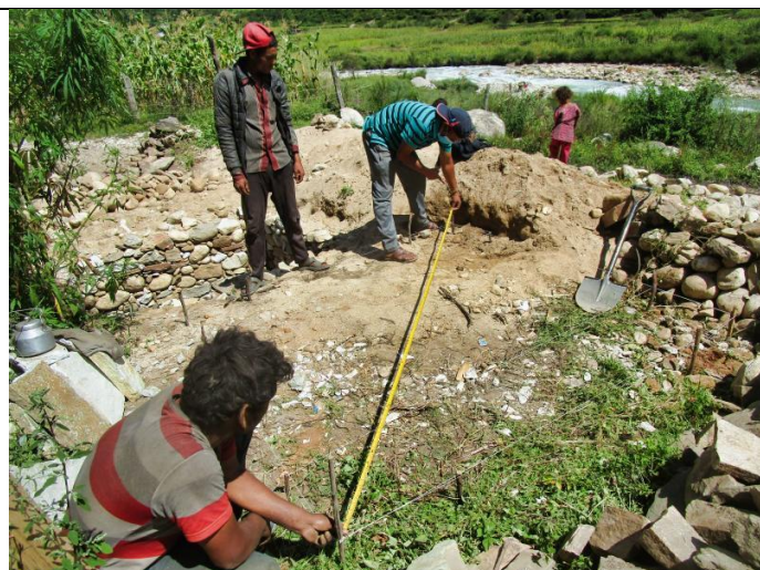
Bild 1: Das Steinhausfundament der Toilette wird vermessen, um sicherzustellen, dass die Innengröße der Toilette dem Design von RIDS-Nepal entspricht.
