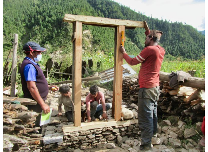
Bild 17: Mitarbeitende von RIDS-Nepal zeigen den Familien, wie sie die Steinmauern um die im Lot stehende Türe herum bauen können.
