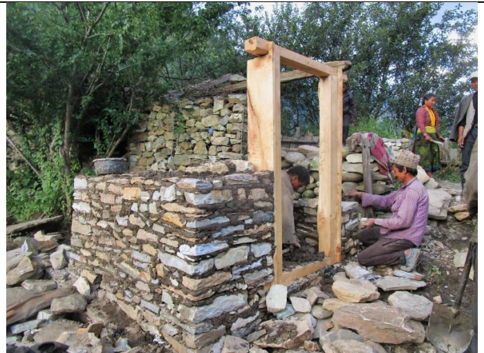
Bild 19: Die Toilettenmauern müssen präzise den Vorgaben von RIDS-Nepal entsprechen.
