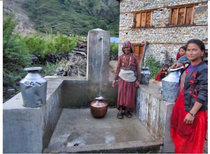
Bild 29: Morgens für 2 Stunden und abends für 2-3 Stunden kann an 10 neuen, im ganzen Dorf verteilten Zapfhähnen Wasser geholt werden. Jetzt verfügt Pere über ausreichend Wasser für alle Familien und ihre Tiere, sowie für die im Bau befindlichen Grubentoiletten.
