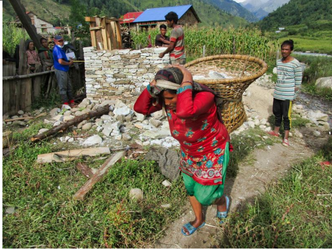
Bild 3: Alle Steine werden in den umliegenden Gebieten gesammelt und ins Dorf transportiert, bevor sie vom Maurer zur richtigen Grösse zerkleinert werden.
