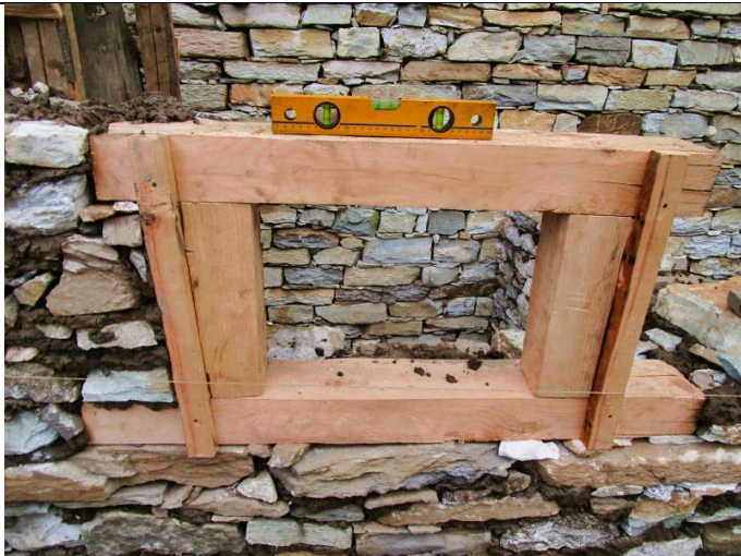
Bild 18: Das Fenster für die Belüftung wird mit der Wasserwaage ausgerichtet, bevor es in die im Bau stehende Steinmauer integriert wird.
