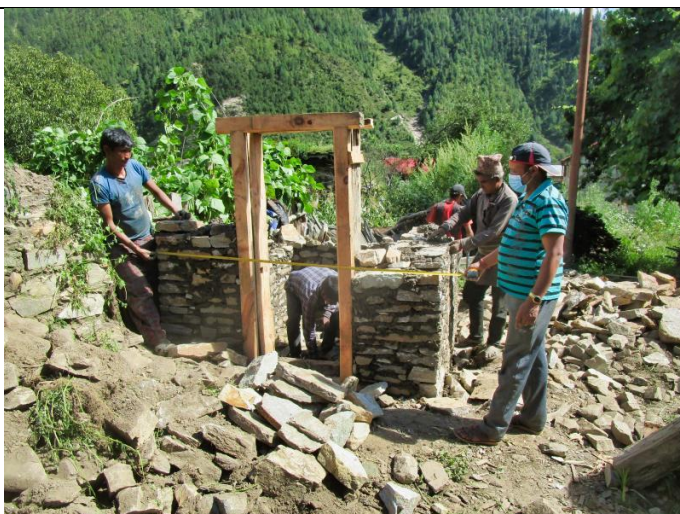
Bild 20: RIDS-Nepal Mitarbeiter Mansingh prüft mit einem Messband, ob die Toilette korrekt erstellt wird und berät die Familie, falls Anpassungen notwendig wären.
