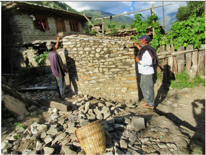
Bild 24: Vermessungsarbeiten bei einem fertiggestellten Steingebäude.
