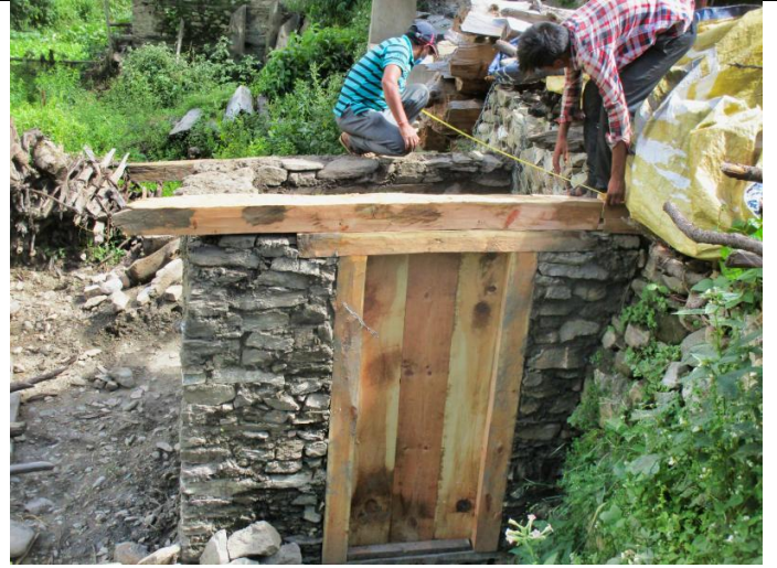
Bild 23: Die Tragbalken des Toilettendachs müssen genau die vorgeschriebene Grösse aufweisen, damit die drei verzinkten Blechdächer exakt auf die Toilette passen.
