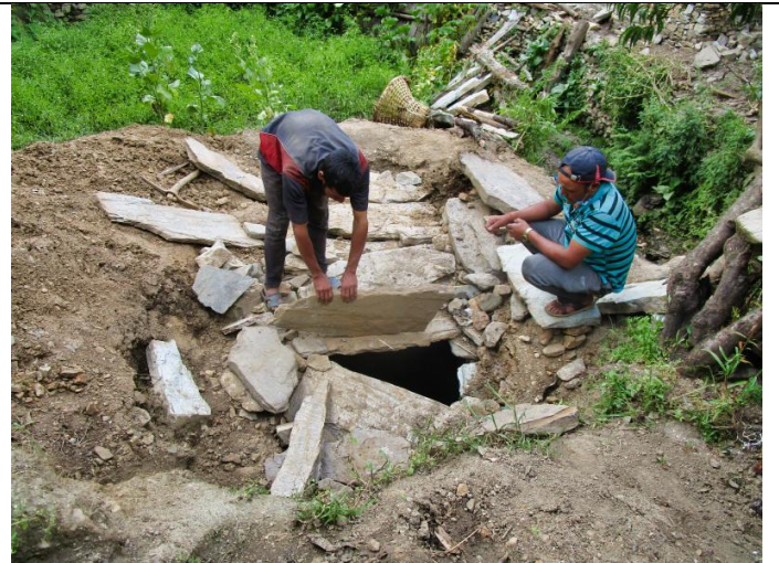
Bild 13: Die verlegten Schiefersteinplatten werden mit Erde zugedeckt.
