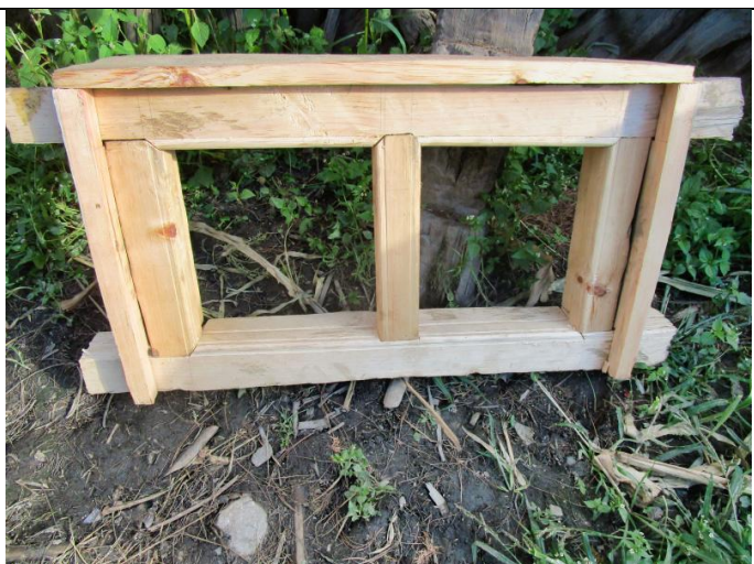
Bild 14: Jede Toilette erhält ein Fenster. Dieses erhellt den Raum und erlaubt eine angemessene Belüftung.
