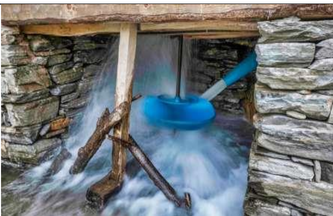
6 neue Metall-Turbinen für 6 neue/renovierte Wassermühlen, die ab Oktober 2022 in Pere gebaut werden.
