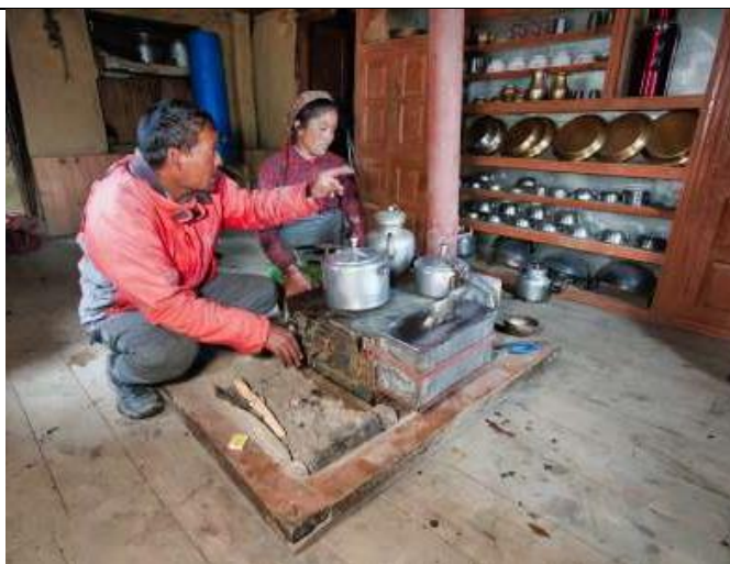
Ein RIDS-Nepal Mitarbeiter instruiert nach der Installation des rauchfreien Metallofens die Frau des Hauses.
