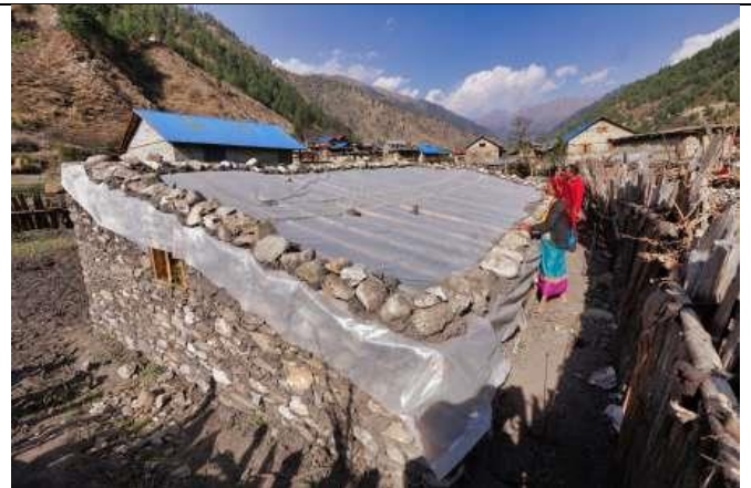
Das neue Gewächshaus einer Familie. 400 mm dicke Steinmauern bilden eine große thermische Masse, welche die tagsüber gespeicherte Sonnenwärme in den kälteren Nachtstunden in den Innenraum abgeben.
