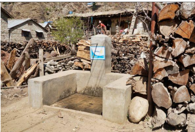
Einer der 15 Pere Dorf-Trinkwasserbrunnen. Jede der 235 Familien in Pere hat in 1-2 Minuten Zugang zu einem Dorfbrunnen, um täglich genügend sauberes Trinkwasser für die Familie zu holen.
