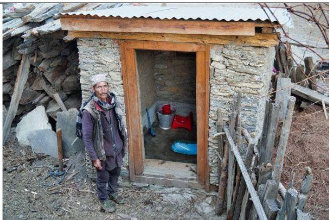
Eine der 229 neuen Grubentoiletten.
