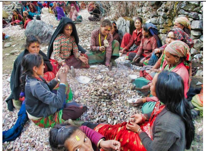
Bild 3: Die Frauen zerkleinern mit Hämmern die grösseren Steine zu Kieselsteinen, um zusammen mit Sand und Zement den Mörtel herzustellen.
