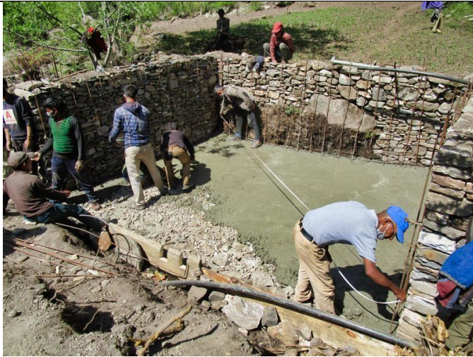
Bild 8: Vermessung und Betonierung des 25 m 3 grossen Fassungstanks unter der Leitung des Trinkwasser-System Experten Bam Bahadur von RIDS-Nepal.
