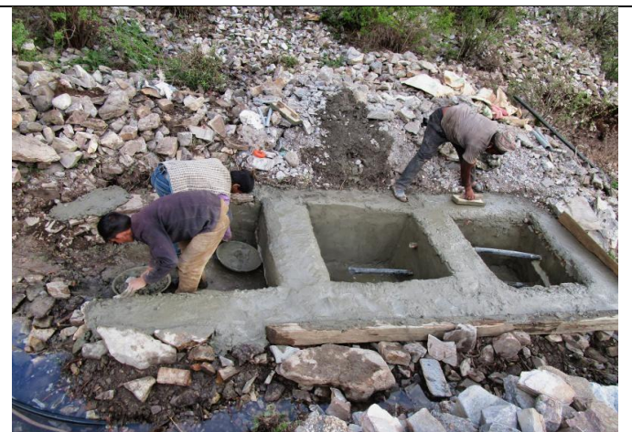
Bild 5: Zur Verhinderung von Verunreinigungen des Wassers werden die Quelfassung und der Sedimentationstank mit Zementwänden und betoniertem Dach geschützt.
