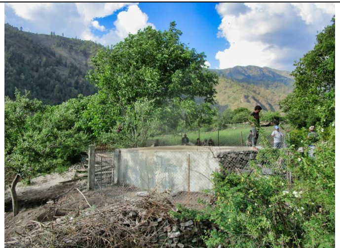
Bild 13: Um Verunreinigungen des Trinkwassers durch Tiere und Menschen zu verhindern, ist der Tank mit Metallgittern und einem Tor gesichert. Schlüssel und Zutritt haben nur berechnigte Kontroll- und Bedienungspersonen.
