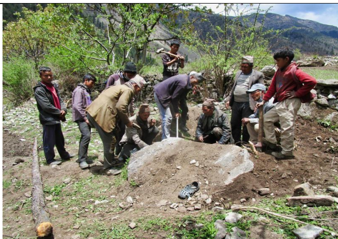
Bild 4: Ein Steinbrocken, der den Zugang zur Quelfassung blockiert, wird in stundenlanger Arbeit mit Hämmern in kleine Steine zerschlagen und entfernt.
