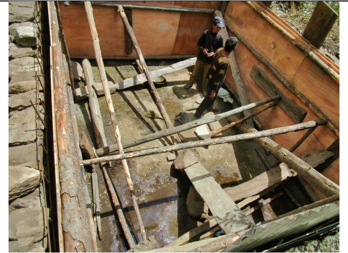
Bild 9: Zugeschnittene Metall-Stäbe dienen zur Verstärkung der zementierten Wände des Tanks. Sie erhöhen die Lebensdauer und helfen Lecks zu verhindern.
