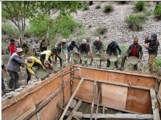
Bild 10: Der benötigte Zement wird unter der Aufsicht des Experten von RIDS-Nepal mit dem im Fluss gesammelten Sand (vgl. Bild 2) sowie den zubereiteten Kieselsteinen (vgl. Bild 3) hergestellt und von Hand zur Baustelle getragen.
