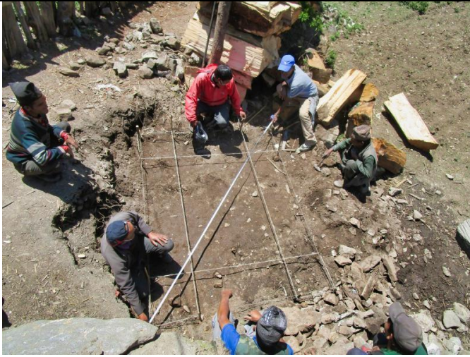
Bild 18: Bam Bahadur von RIDS-Nepal instruiert Dorfbewohner über korrekte Fundamentarbeiten und Errichtung der Wasserzapfstellen.
