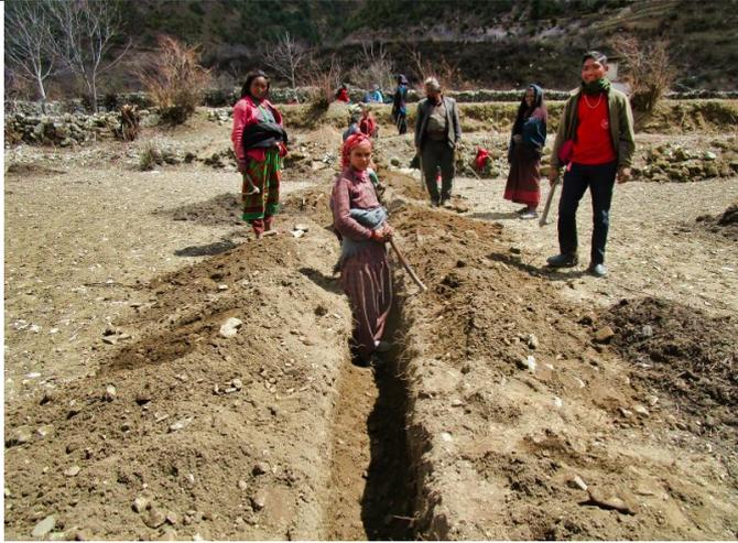
**Bild 7:** Die Gräben werden 50cm - 60cm tief und 50 cm breit erstellt damit auch im Winter das Wasser in den Leitungsrohren nie gefriert. Personen des vom RIDS-Nepal trainierten PIC Teams überprüfen die Einhaltung der vorgeschriebenen Tiefe.
