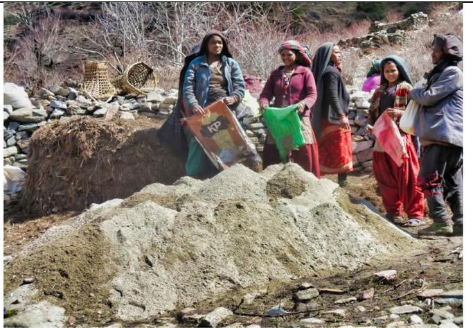
**Bild 4:** Der nötige Sand für alle Zementarbeiten wird dem lokalen Flussbett entnommen. Dieser wird gesiebt damit die richtige Sandkörnung erreicht wird.
