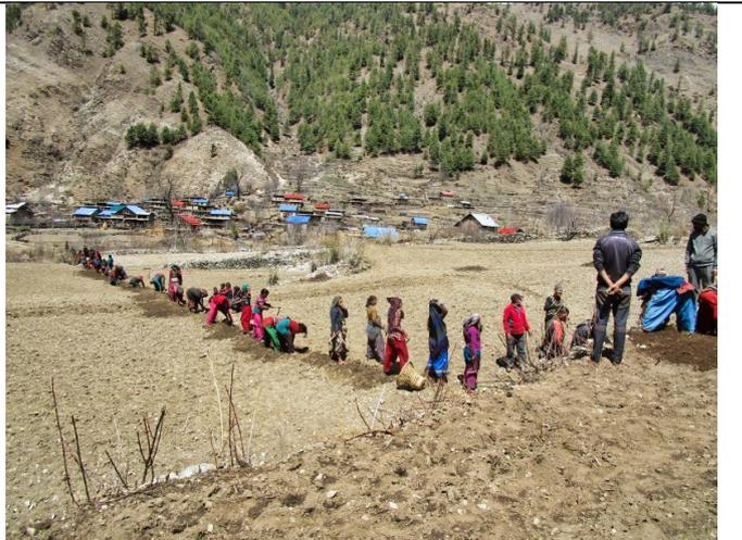
**Bild 6:** Die Bewohner erstellen die Gräben für das Dorftrinkwassersystem. Alle zwei Meter gräbt eine Person, damit in möglichst kurzer Zeit die ganze Wasserleitung verlegt werden kann. Jede Familie entsendet jeden Tag mindestens eine Person zur Mitarbeit am neuen Dorftrinkwassersystem.
