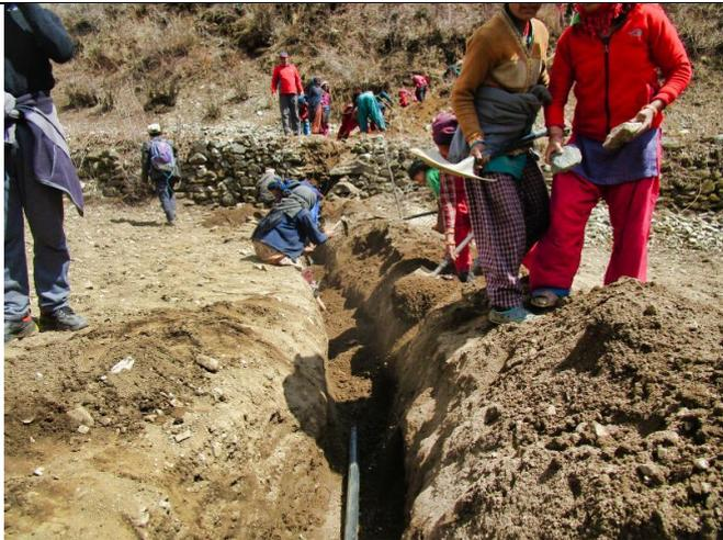
**Bild 9:** Das verlegte HDP Wasserleitungsrohr wird mit Steinen belegt damit sich deren Position nicht verschiebt. Dadurch wird es bestmöglich gegen unvorhergesehene Beschädigungen geschützt; sei es durch landwirtschaftliche Arbeiten, gefrieren im Winter oder künftiges Graben. Da die Wasserleitung genügend tief unter der Erde verläuft können die Bauern die darüber liegenden Äcker normal bestellen.
